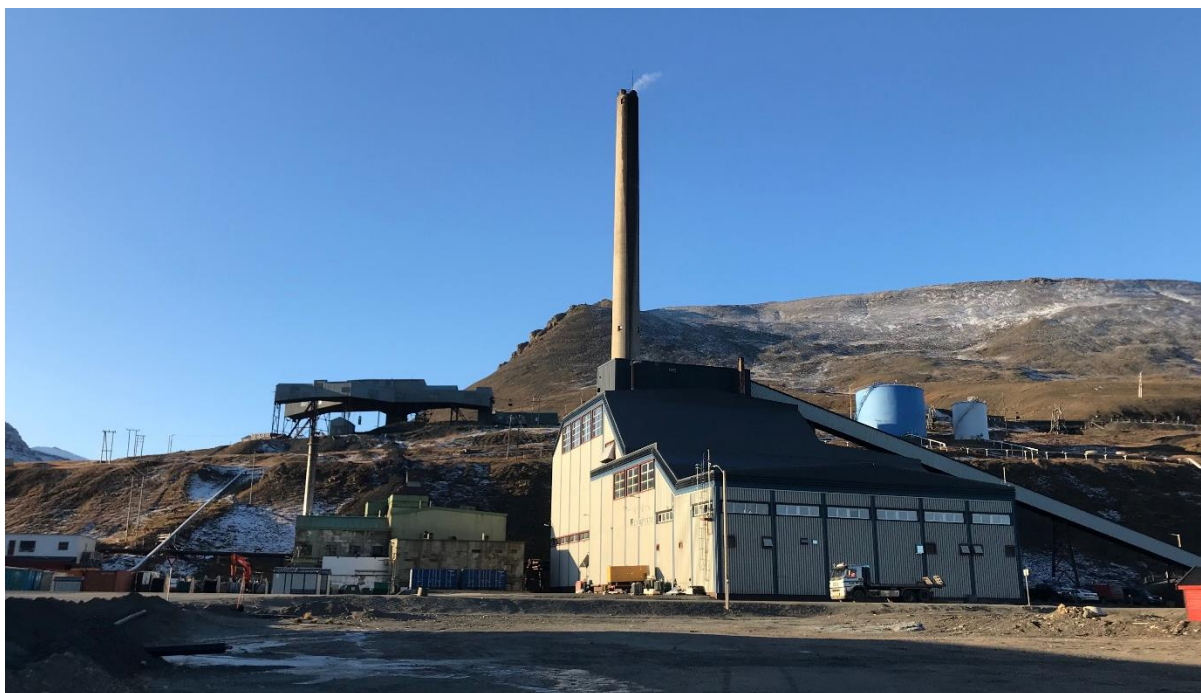
Kullkraftverket i Longyearbyen, september 2018. Foto: Dag Brekke
