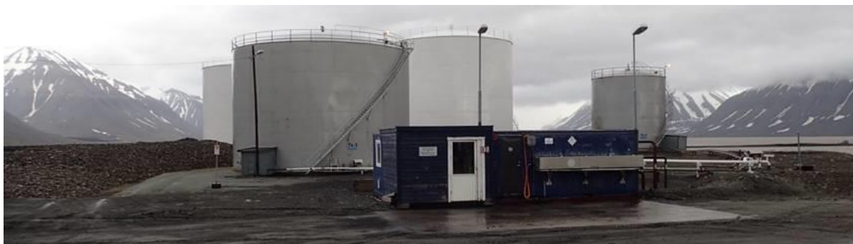
Tankanlegg for diesel i Svea. De største tankene er 5200 \text{ m}^3 , Samlet kapasitet er 17\,800 \text{ m}^3 .
